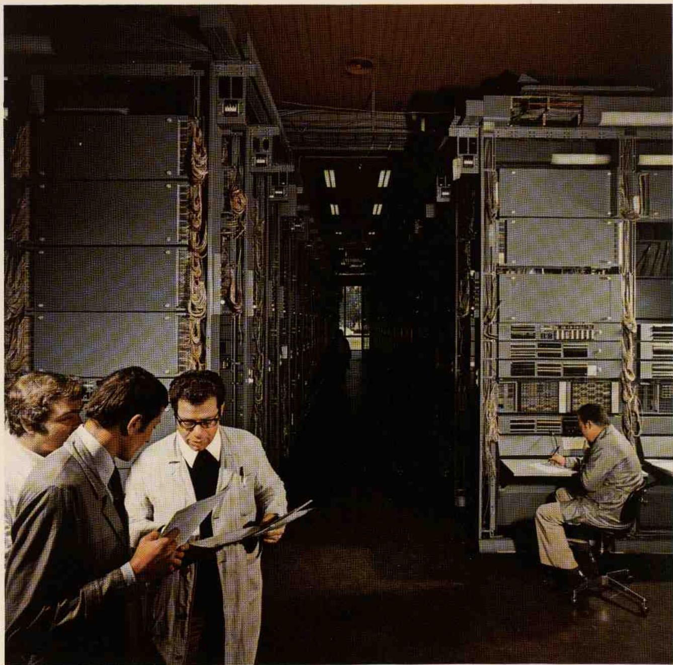
Italcable - Centri Operativi di Acilia - Sala Autocommutatore « Pentaconta »
