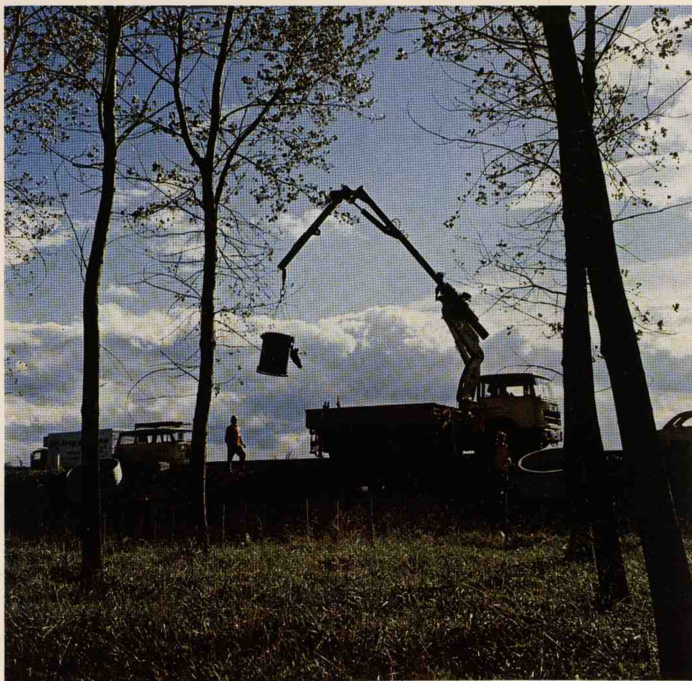
Sirti - Rete autostradale in cavo coassiale - Posa di un contenitore per amplificatori a 60 MHz
