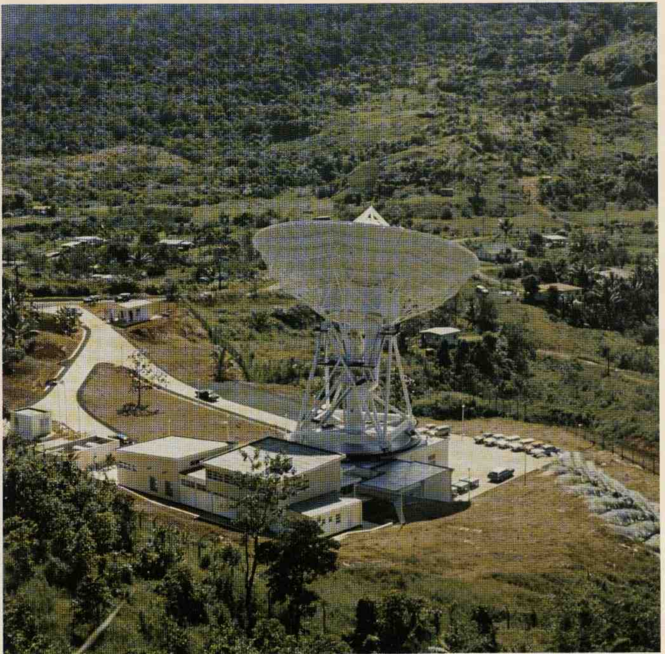
Sts - Stazione terrena per la telecomunicazione via satellite di Wailoku - Isole Fiji
