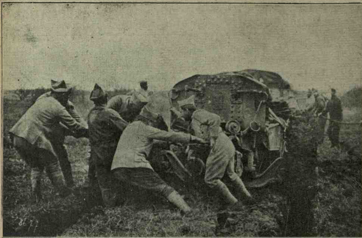
La grande battaglia in Francia. — Messa in batteria d'un cannone da 155. (Fot. Argus - lastre Tensi).
