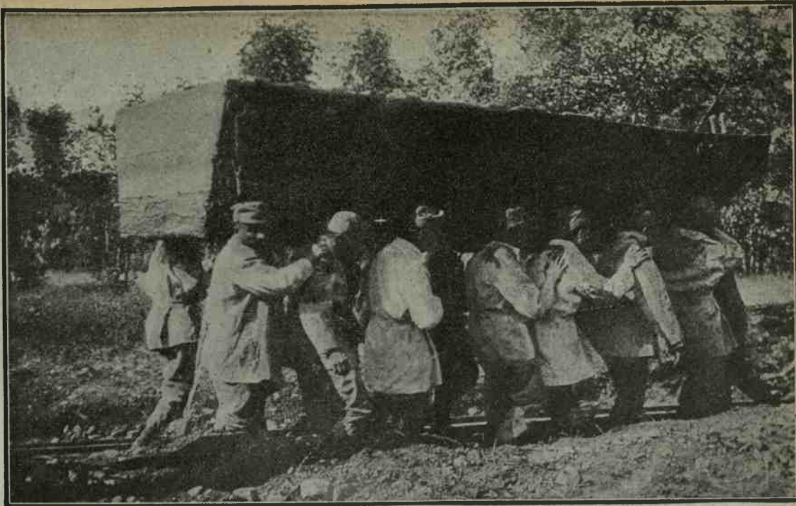
Coi nostri soldati oltre il confine. — I pontieri del 4° genio portano i barconi per la costruzione di un ponte sull'Isonzo. (Fot. Argus - lastre Cappelli).
