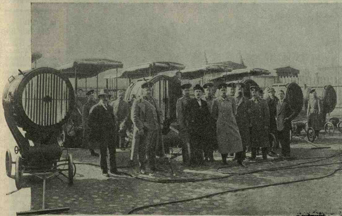
Una Commissione militare Russa collauda un gruppo di vetture fotoelettriche Fiat-Galileo.
