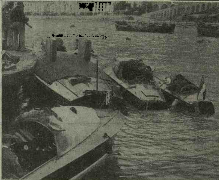
I canotti a riposo. — Dopo le corse, i canotti automobili venivano messi a riposo in una baia del porto di Monaco.
