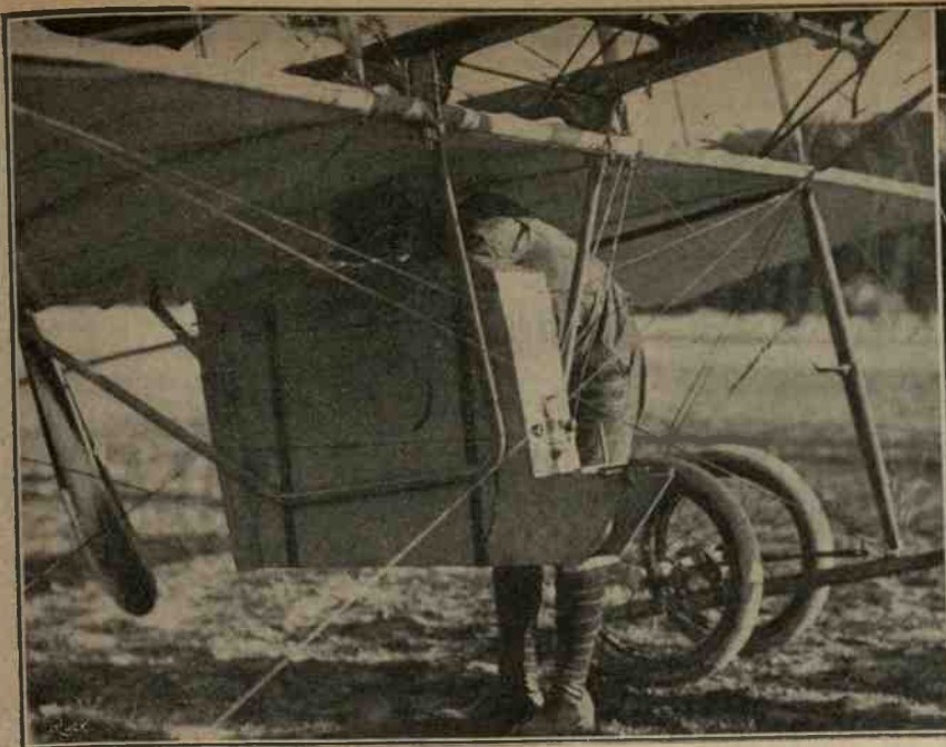
Il concorso dell'Aero Club di Francia per il lancio delle bombe. Il dispositivo del tenente Bousquet.
