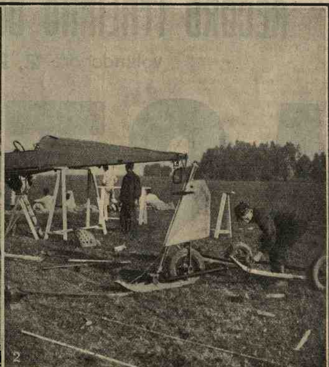
Montatura in campagna di un biplano Bréguet.
