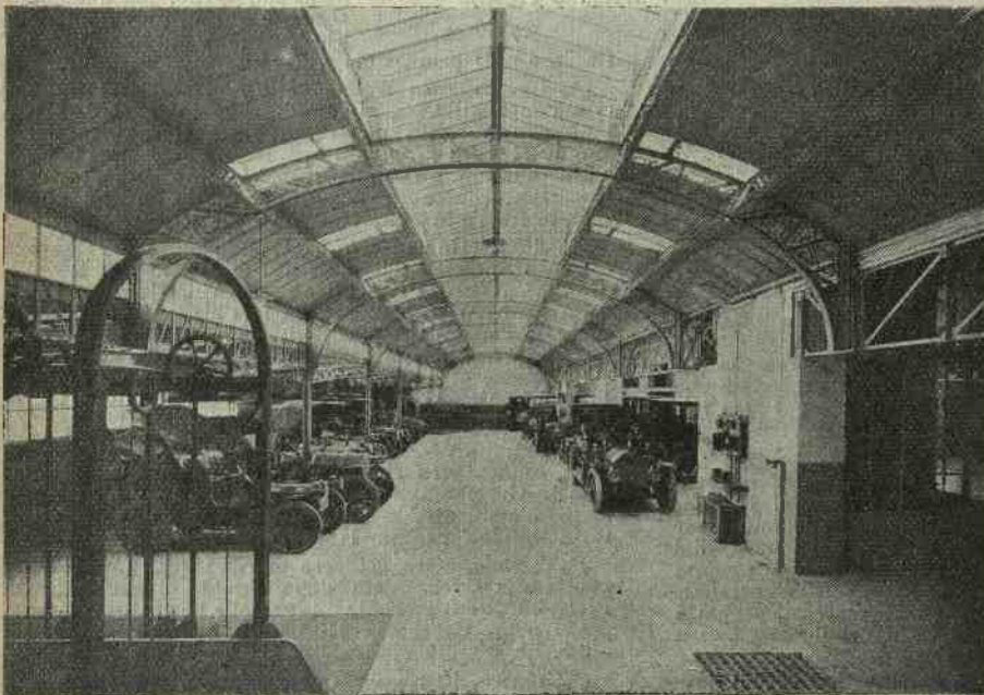
Il nuovo garage dell'Automobile Club di Milano.
