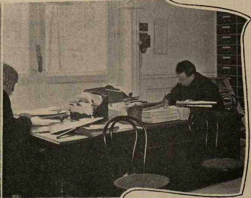
Il servizio di corrispondenza coi soci.
