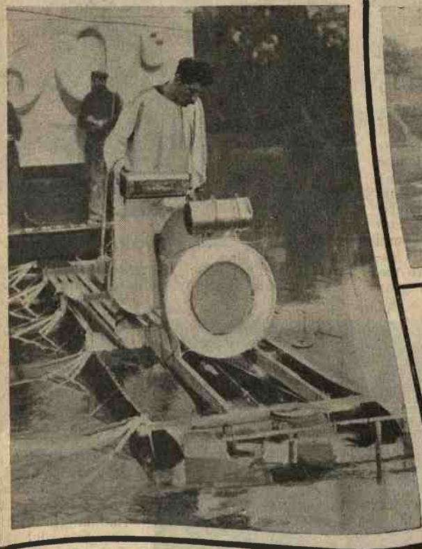
Riempimento dei serbatoi.
