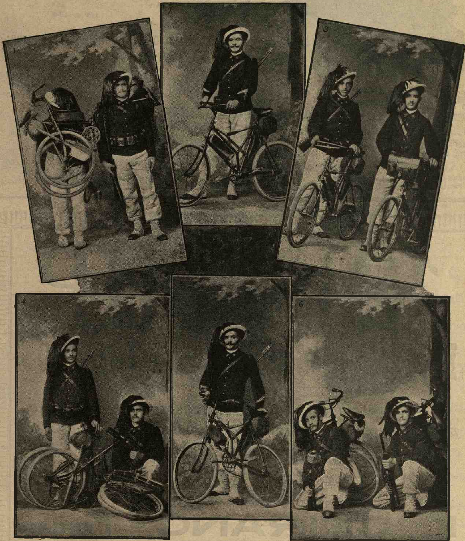
I Bersaglieri Ciclisti. 1. Bicietta pieghevole « Carraro » in ispalla. — 2. Macchina pronta alla partenza. — 3. Bicietta munita di zaino di sanità. — 4. Bicietta piegata. — 5. Come avviene il piegamento della macchina. — 6. La bicietta non impedisce gli esercizi.
