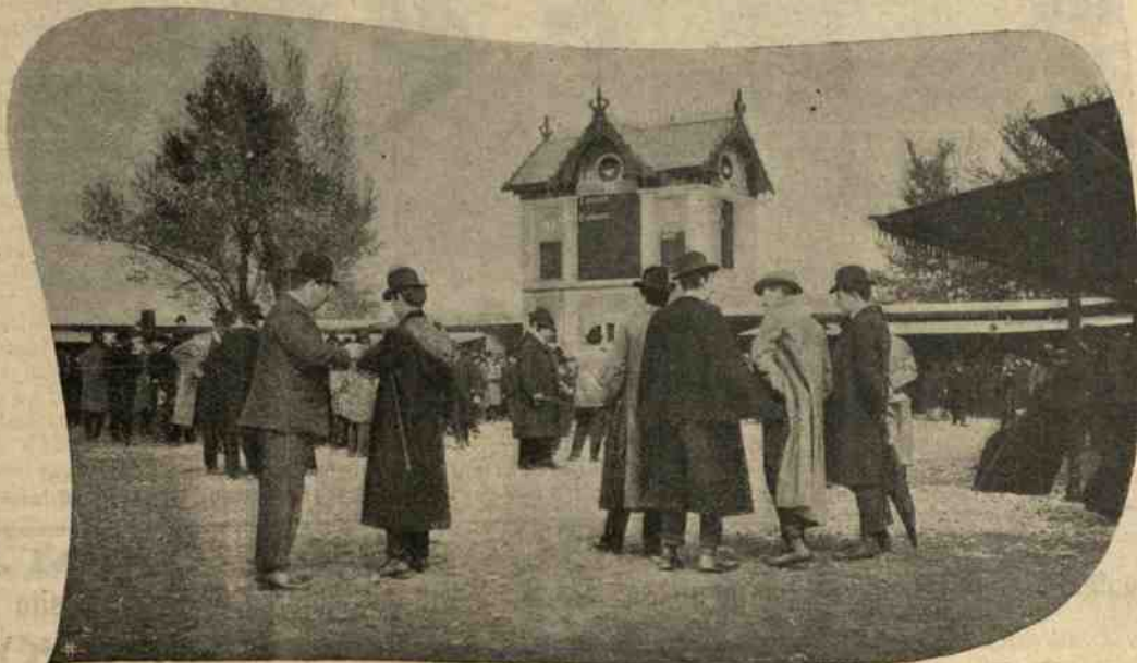
I nuovi capannoni eretti nel prato di San Siro.
