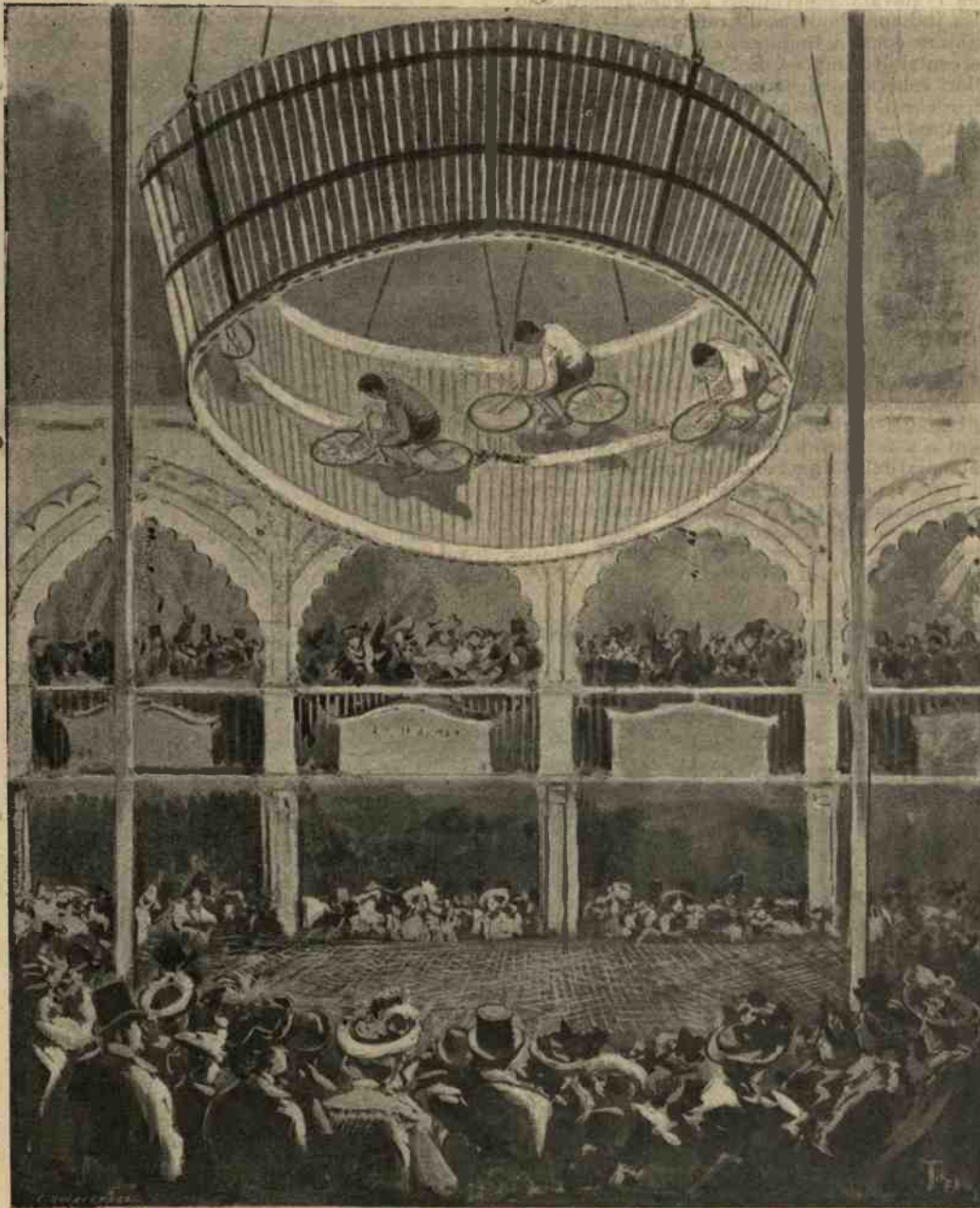
La pista aerea: Allorchè i ciclisti cominciano a girare all'interno, la pista si alza lentamente, a mezzo di carrucole, fino all'altezza di 20 metri.
