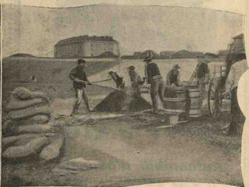
Le piste si fanno in cemento armato, secondo i dettami dell'architettura moderna. Le griglie sono messe parallele ed equidistanti, mentre all'interno della pista si prepara l'impasto di sabbia e cemento.
