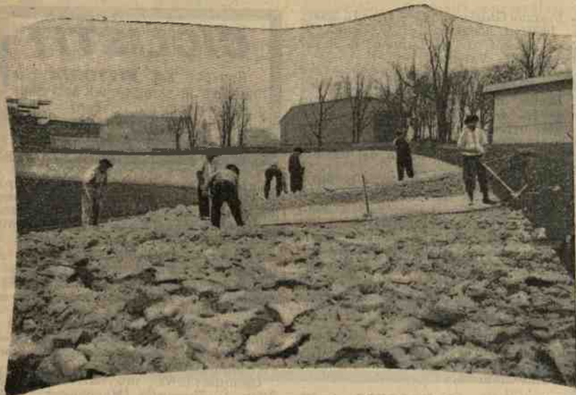
Si comincia dal rompere la crosta di cemento esistente e ad asportarne i rottami; quindi con della terra in più si portano le curve alla voluta altezza. Allora vi si posano le griglie, su cui deve mettersi la nuova superficie di cemento,
