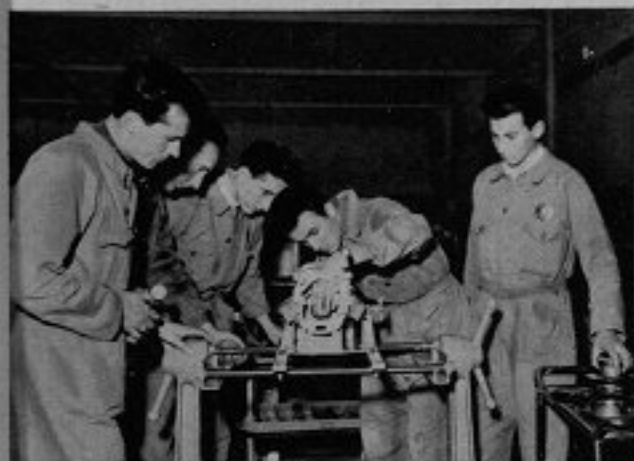
Il complesso del cambio della « 600 » è stato smontato: ora si procede al montaggio. Le varie fasi dell'operazione vengono compiute sotto la guida dell'istruttore Perito industriale Livio Vaudagna (il secondo dalla sinistra), attentamente seguite dagli allievi.
