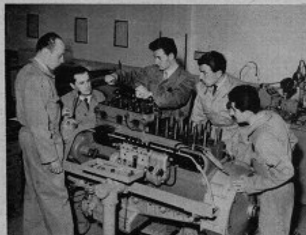
Un gruppo di allievi ingegneri di officina durante la dimostrazione pratica del rimontaggio di una delle due teste del motore dell'autocarro 682 Fiat. Sta operando l'istruttore Angelo Curati (il terzo da sinistra). Nella foto, gli ingegneri Marzari, Gaidano e Roman.
