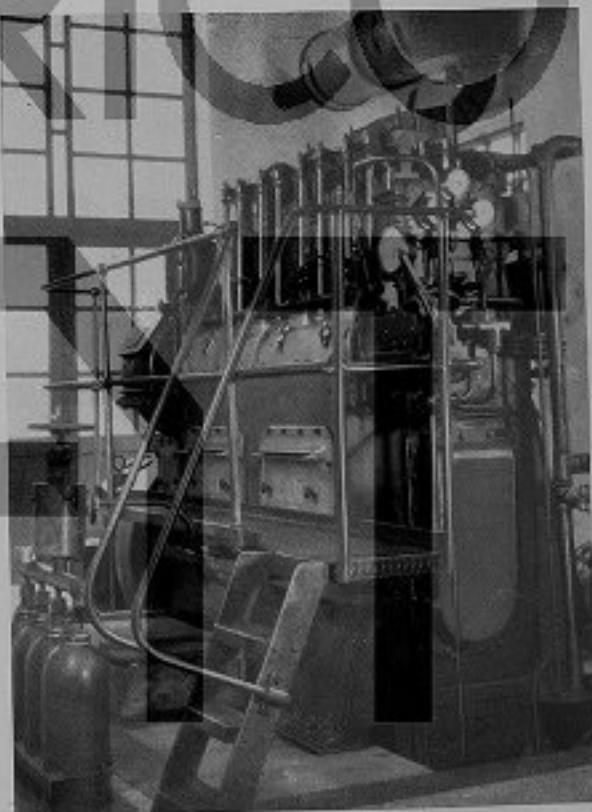
Fig. 7 - Gruppo elettrogeno da 140 kW 50-385 sistemato presso lo stabilimento Dell'Orto di Milano.
