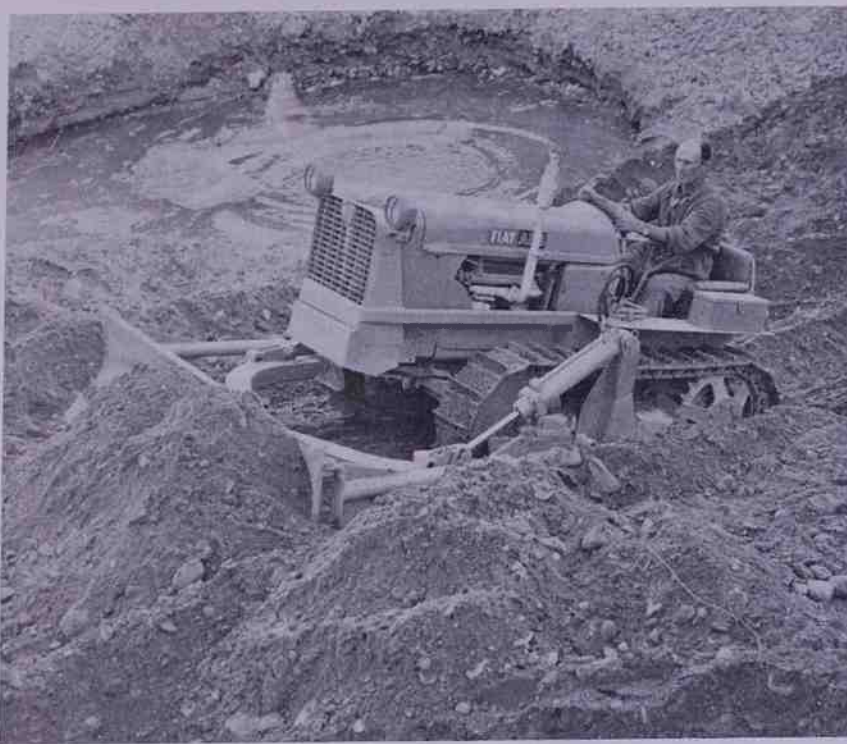
Angledozer in azione nello scavo d'un bacino di raccolta delle acque di circolazione interna ed esterna eccedenti la capacità idrica dei terreni: bacino che potrà poi servire per la irrigazione.
