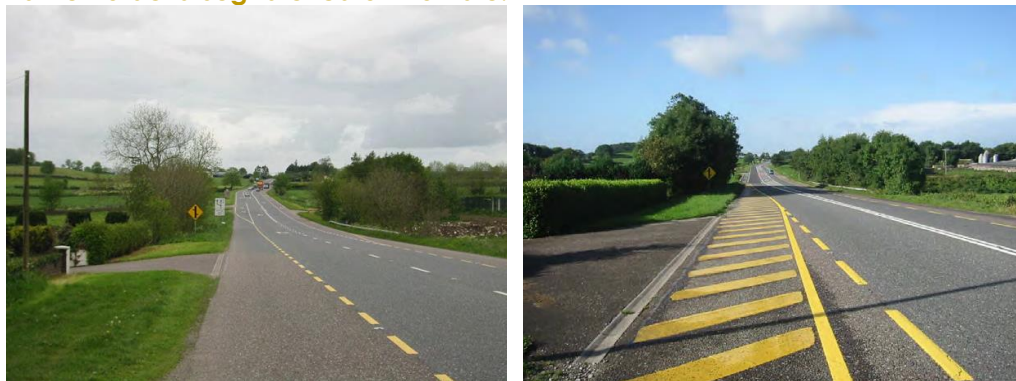
Fig 3.1 Aggiunta di una corsia riservata per l'immissione da una strada secondaria e potenziamento della segnaletica orizzontale.
