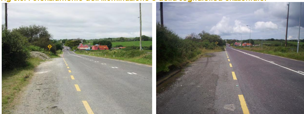
Fig 3.3. Potenziamento dell'illuminazione e della segnaletica orizzontale.
