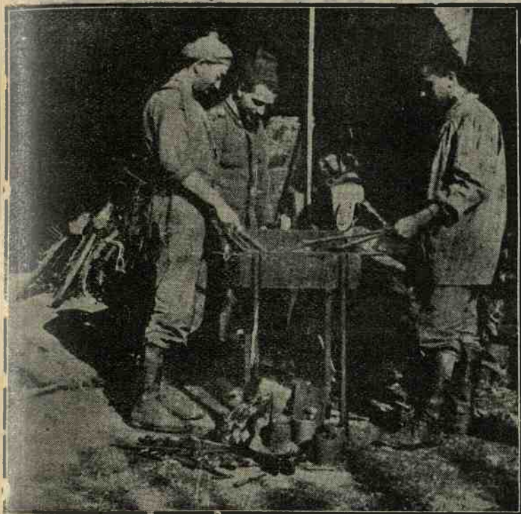
La nostra guerra. — Fucina portatile di un battaglione di bersaglieri ciclisti. (Fot. Argus - lastre Tensi).
